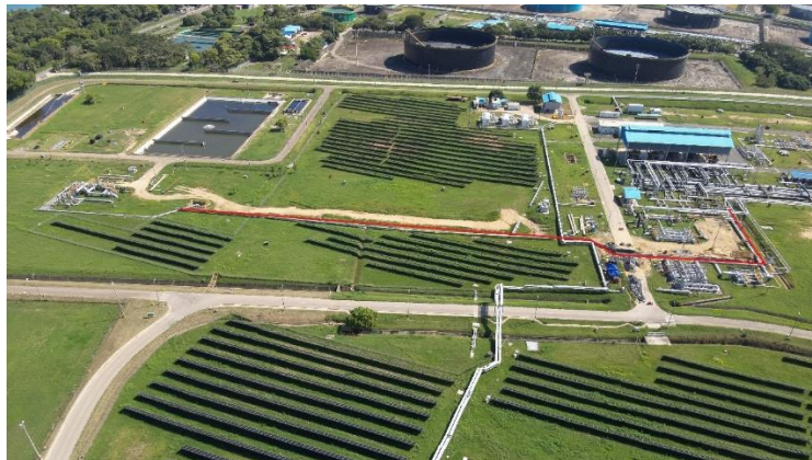
Tramo reemplazado de 300 metros de tubería de 30" de diámetro (línea roja)
